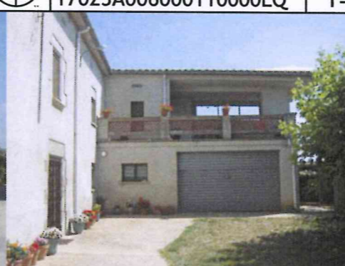
Façana oest (ampliació)
