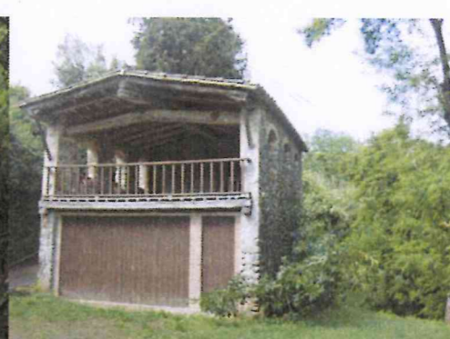
Façana este annex
