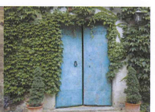
Detall porta façana oest
