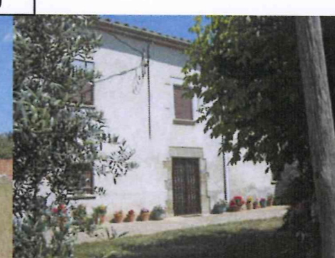
Façana sud (volum original)
