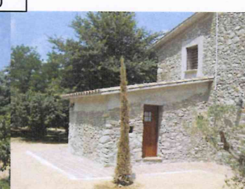
Annex façana sud
