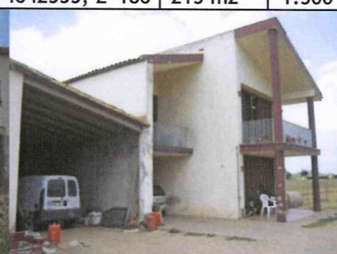
Façana sud- ampliació est
