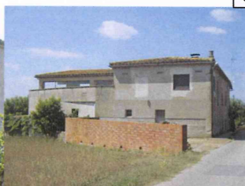
Façana est (ampliació)
