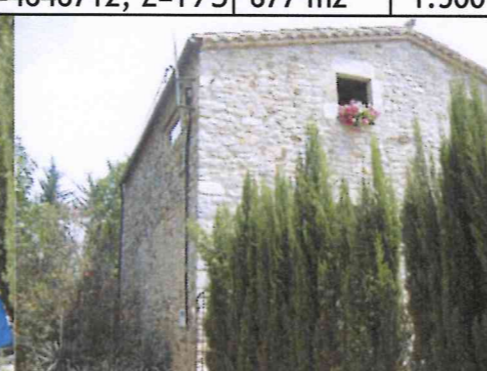
Façana sud i oest
