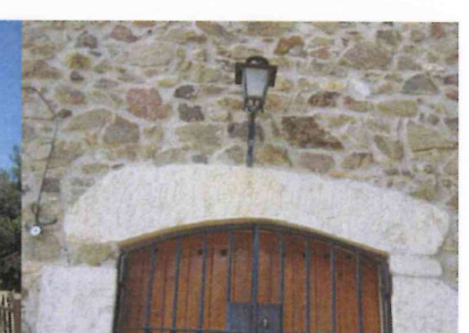
Detall llinda façana sud
