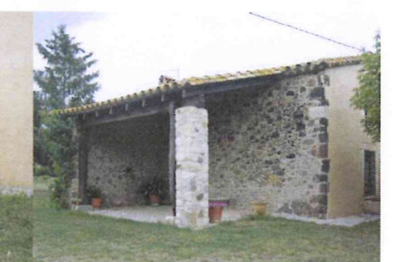
Porxo façana oest
